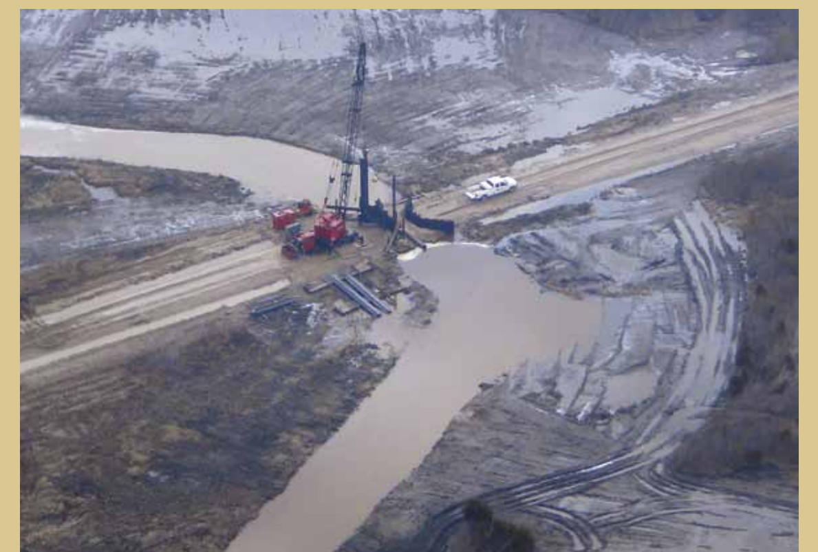
正在安装的一个 South Cape May 堰
